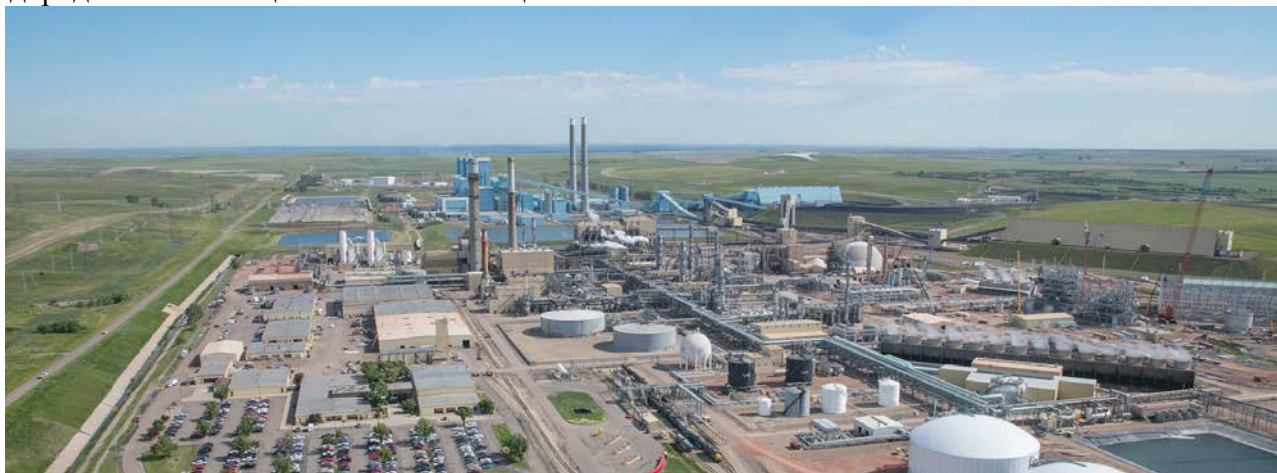
Dacota gasification Company (газификация и метанизация на лигнитни въглища, капацитет 4.1 млн. Nm 3 синтетичен метан на ден)
